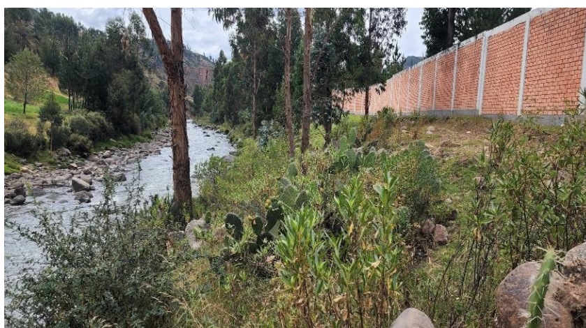
FIGURA N°03: VISTA DE MURO PERIMETRICO ALEDAÑOS A LA RIVERA DEL RIO VINCHOS, LOS MISMOS QUE ESTAN SIENDO EROSIONADOS Y SOCAVADOS EN EPOCA AVENIDAS.
